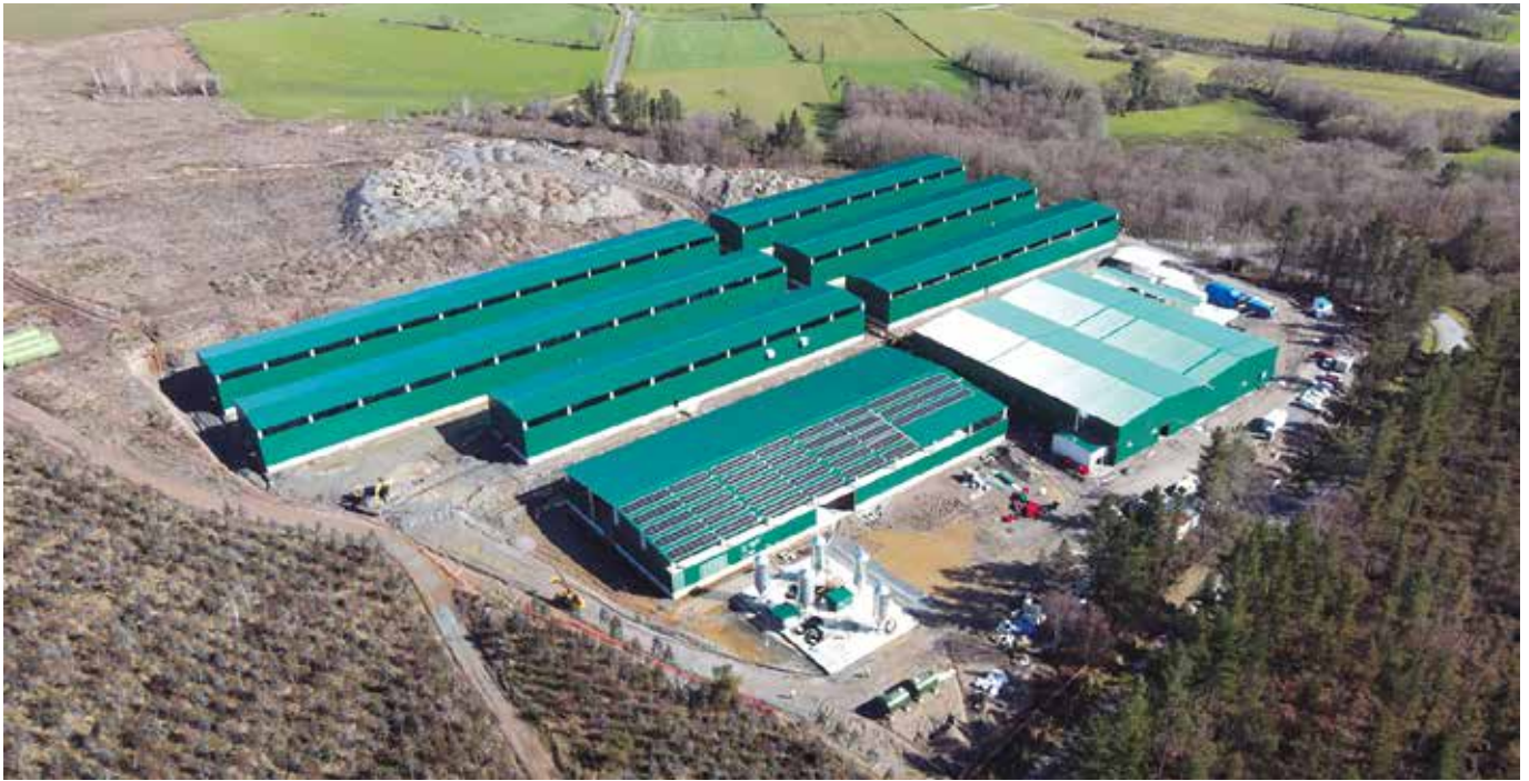
Instalaciones en Palas de Rei (Galicia). Foto: Bioflytech.
