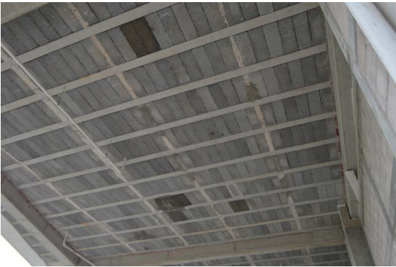
Vigueta, bovedilla y nervio de temperatura
