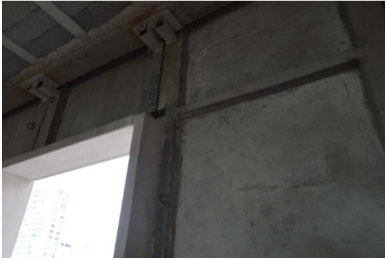
muros prefabricados, soldados a la losa
