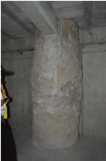
pilote de concreto con cimbra de tierra
